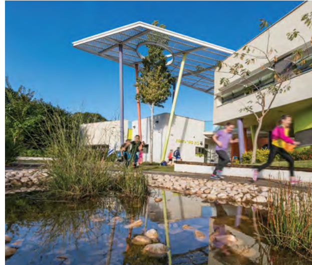
בית הספר רקפות, קריית ביאליק. בית הספר תוכנן כמבנה ירוק בראייה אדריכלית פסיבית בעזרת העמדה נכונה, בידוד משמעותי, תכנון מערכות הצללה לחללי הפנים והחוף ושימוש בחומרים ירוקים. בבנייה שולבו מערכות חכמות לשימור האנרגיה | צילום: אלעד גונן
